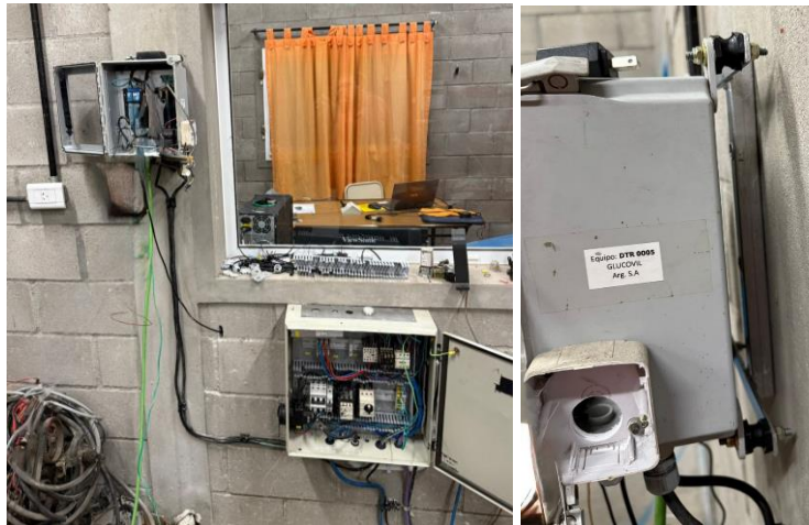
Figura 64. Nueva ubicación y detalle de montaje del tablero de comando.
