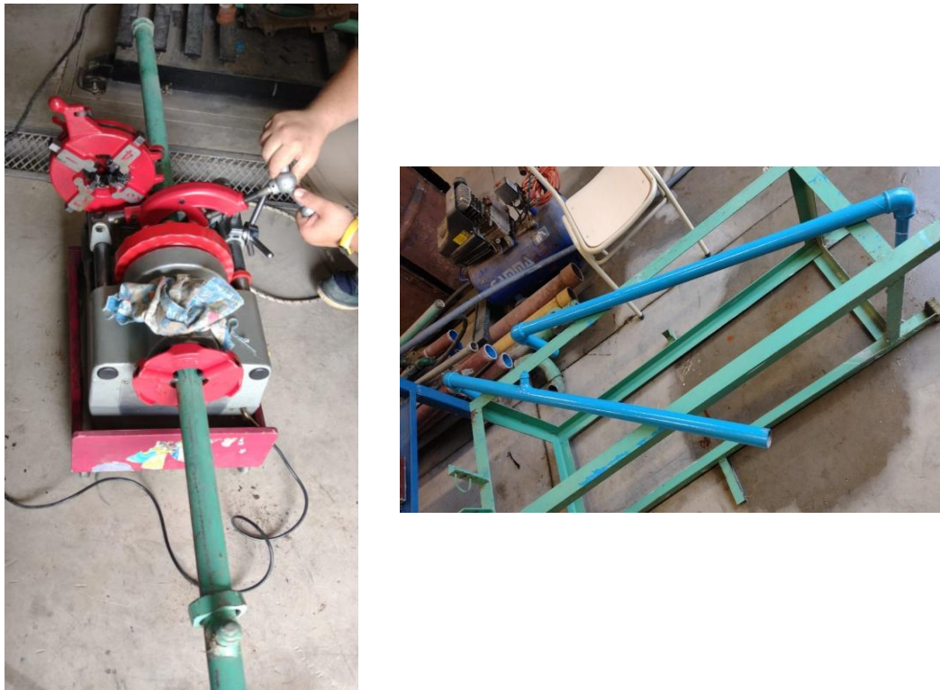
Figura 13. Proceso de corte/roscado/pintura de las cañerías.
