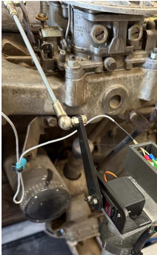
Figura 59. Instalación del servomotor.
