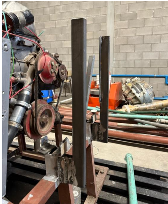
Figura 20. Soporte del electro ventilador soldado.
