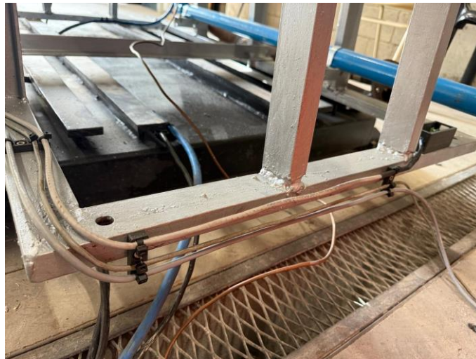
Figura 47. Cables del medidor de RPM, celda de carga y MAX6675 de temperatura de freno fijados a la base del banco de ensayos.
