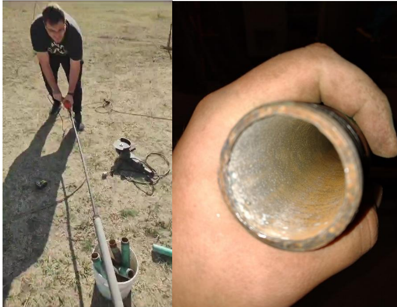
Figura 12. Proceso de limpieza interna de la cañería.
