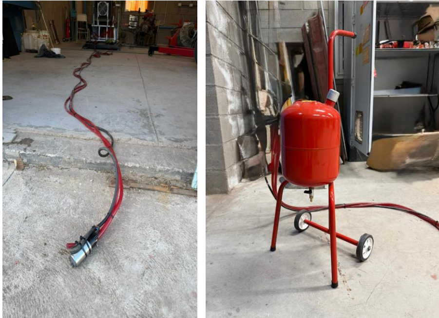
Figura 61. Instalación de nafta realizada y demostración de longitud y ubicación en el exterior para el tanque de combustible.
