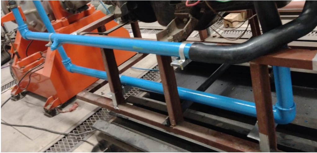
Figura 16. Fijado de las cañerías.
