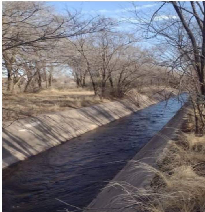
Figura N°13 – Canal Paso de las Carretas. [11]
