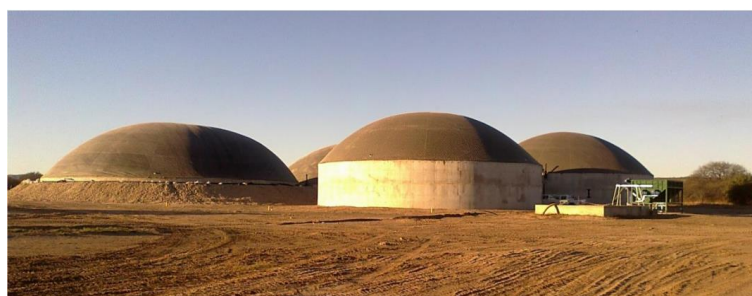
Figura N°11: Biodigestor mezcla completa de alta tecnología.
