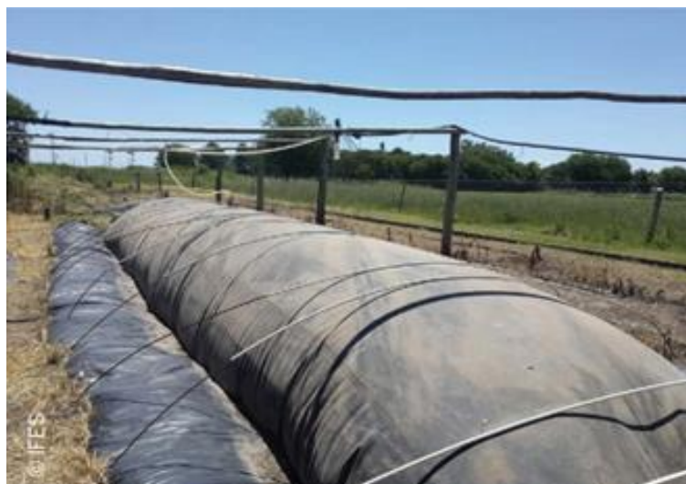
Figura N°10: Biodigestor construido de membrana de PVC.
