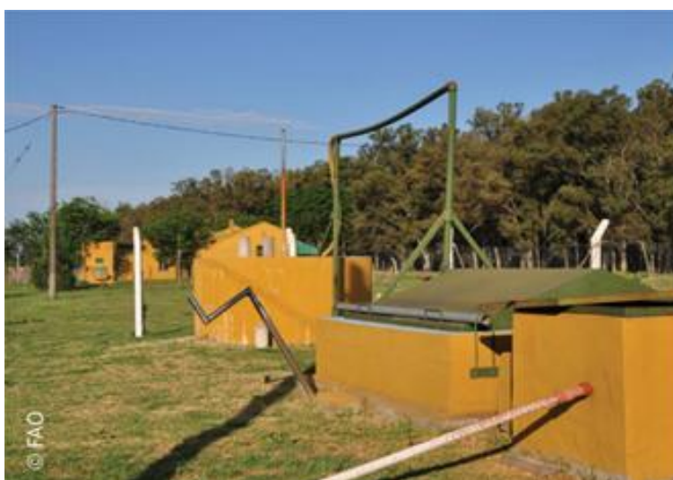
Figura N°9: Biodigestor tipo chino.
