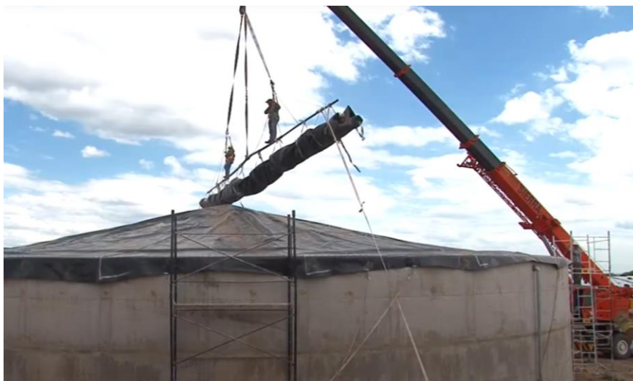
Figura 29. Instalación de cubierta en biodigestor.
