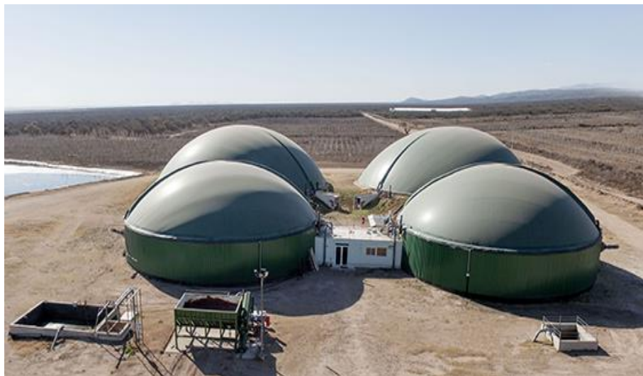
Figura 3: Sistema compuesto por reactores mezcla completa.
