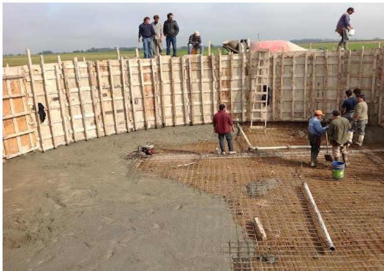
Figura 39: Construcción de reactor anaeróbico.
