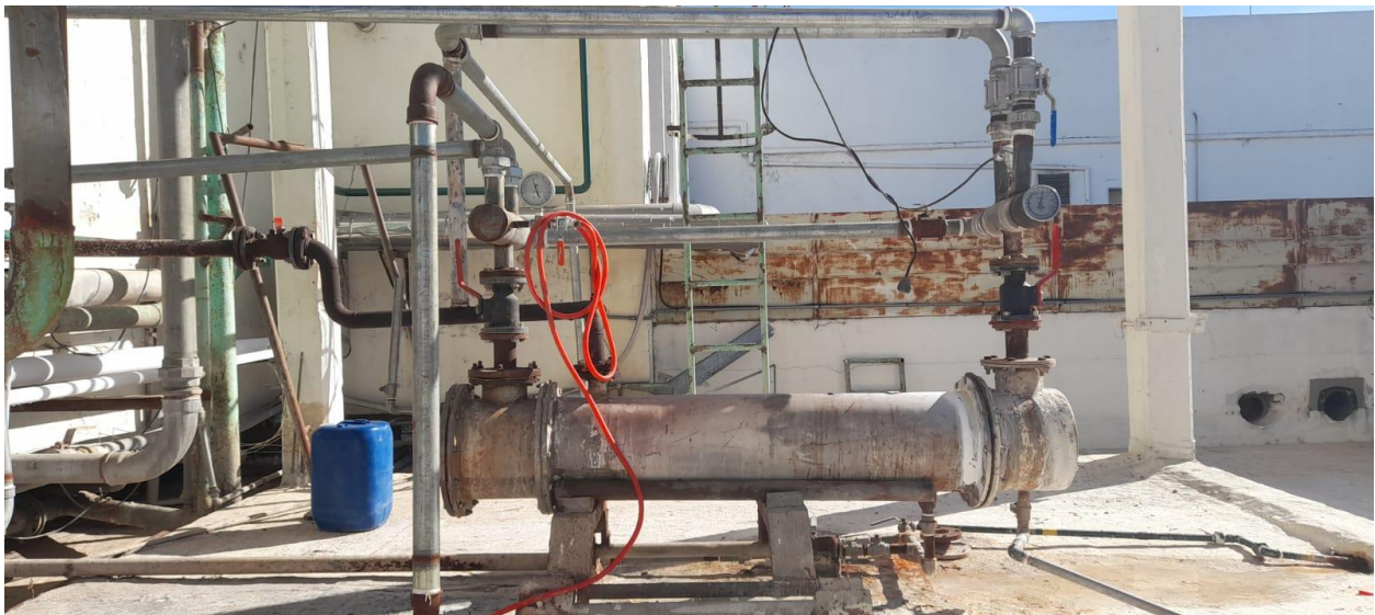
Figura 17. Intercambiador intermedio
