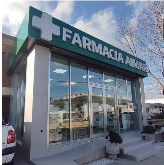
Fig. 8: FACHADA ACTUAL DE LA FARMACIA. Fuente: Elaboración propia.
