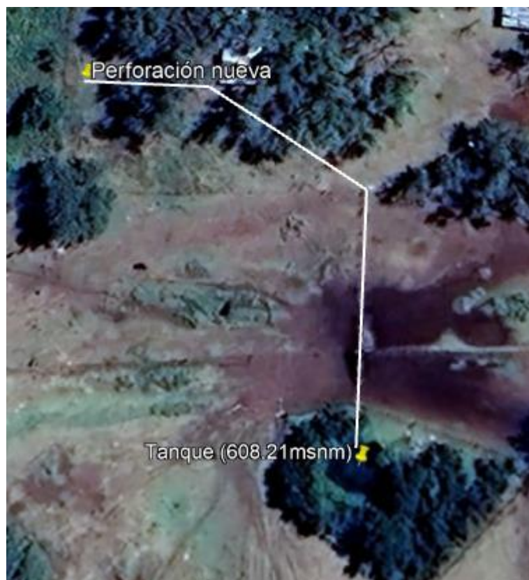
Figura 11. Recorrido de la cañería desde la bomba hacia el tanque.
