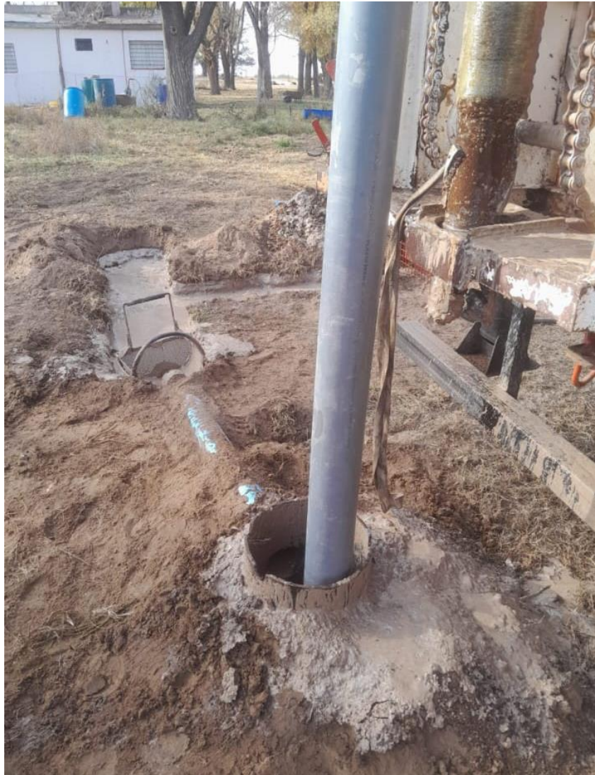
Figura 7. Proceso de recirculación de Bentonita.
