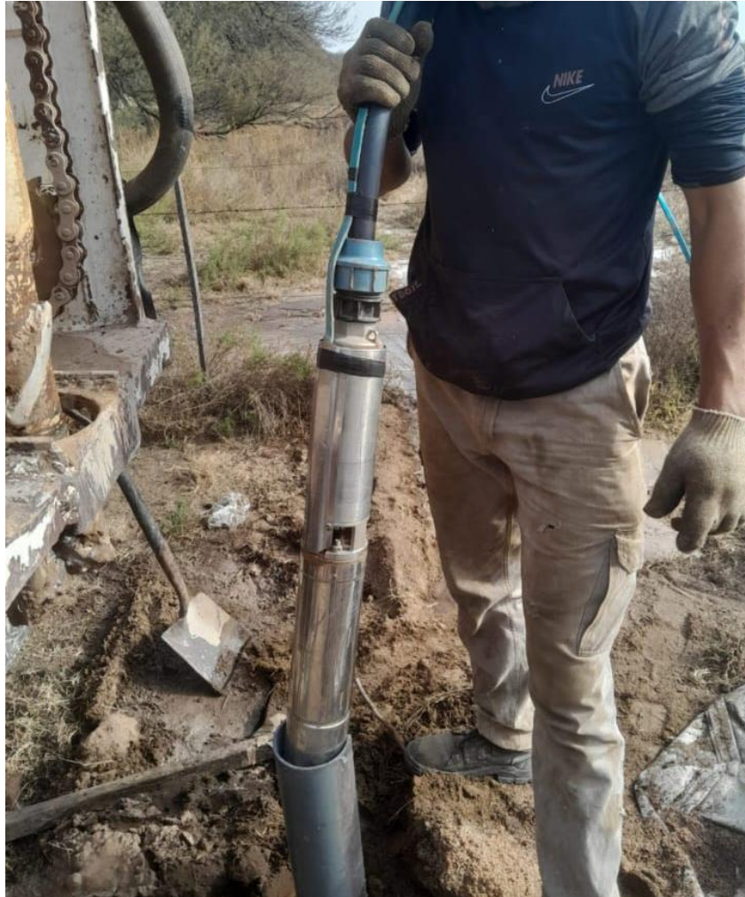
Figura 9. Colocación de bomba sumergible.
